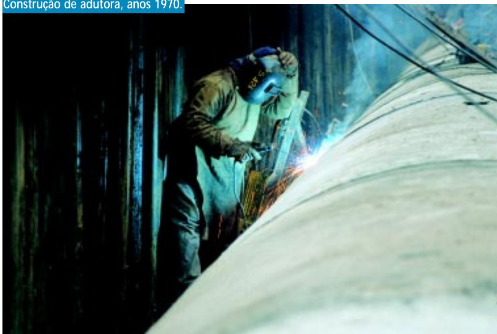
Construção de adutora, anos 1970.
