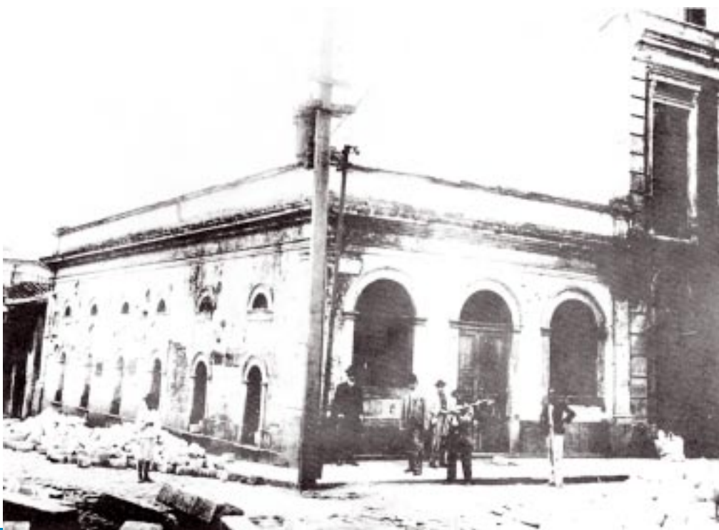
Prédio da caixa d'água construído em 1858.
