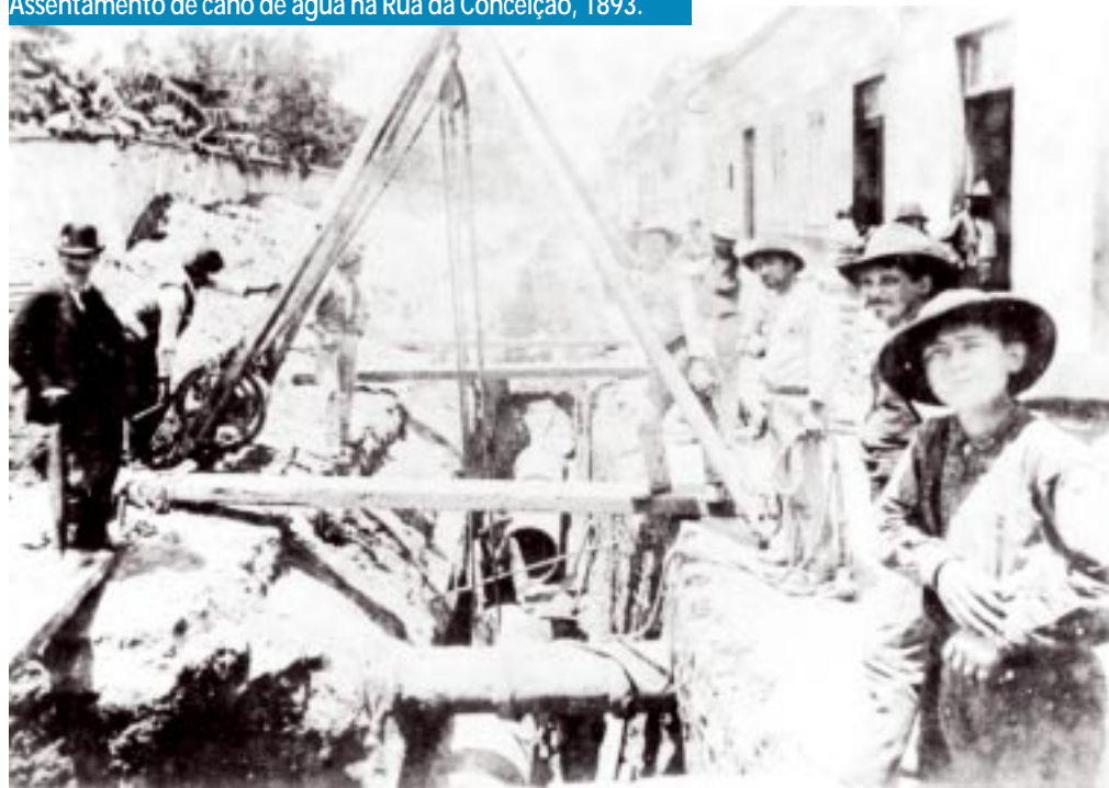
Assentamento de cano de água na Rua da Conceição, 1893.
