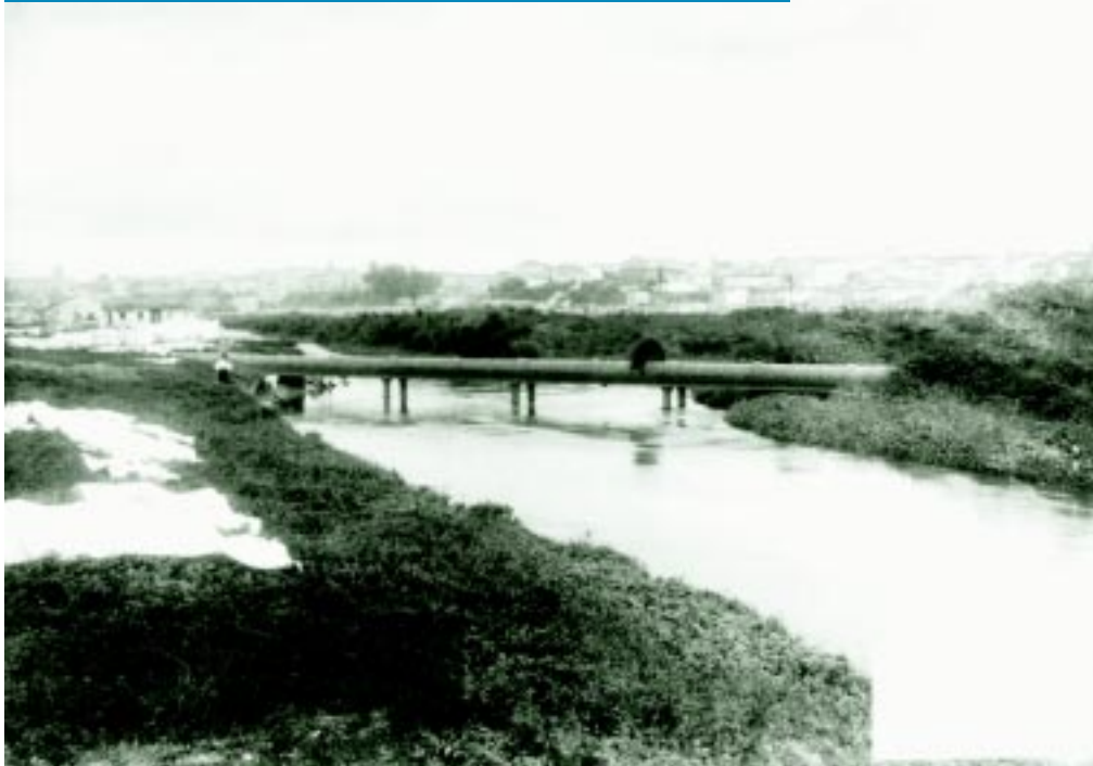
Adutora sobre o Rio Tamanduatei, 1900. Foto em direção ao centro.
